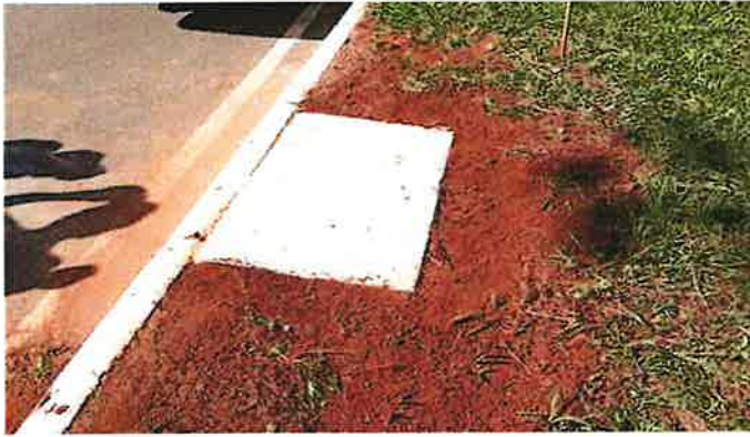
• REPOSIÇÃO DE LAJES DE POÇO DE VISITA
